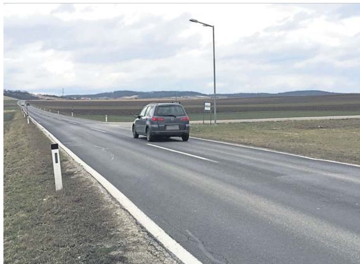
Besonders für Abbieger ist die Einmündung der Hollabrunner Heiligstraße in die Landesstraße B 40 (Richtung Wieselsfeld) gefährlich. Jetzt konnte diese Kreuzung entschärft werden. Foto: privat
